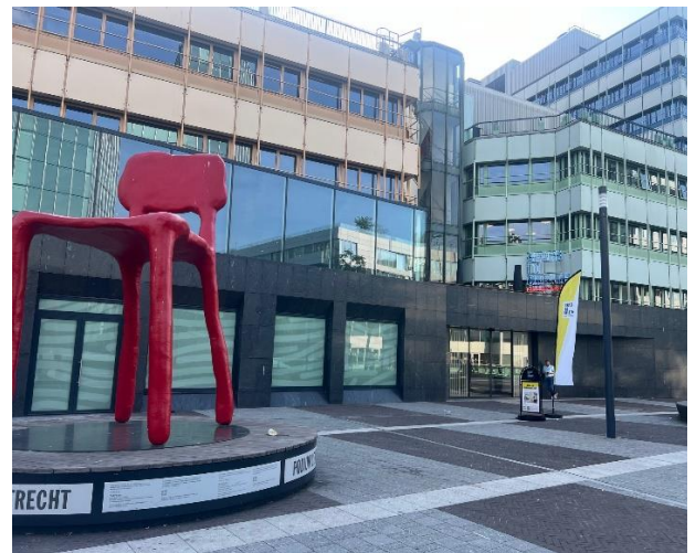
Bel aan bij de schuifdeuren links onder Space to Create (verticaal knopje naast het naamplaatje van Bevolkingsonderzoek). Op de schuifdeur staat: Kantoren Van Duvenborch, Stationsplein 89, 90 91, 97 en 109. Na het aanbellen wordt de deur automatisch geopend. U hoeft verder niets in te spreken of te doen.
